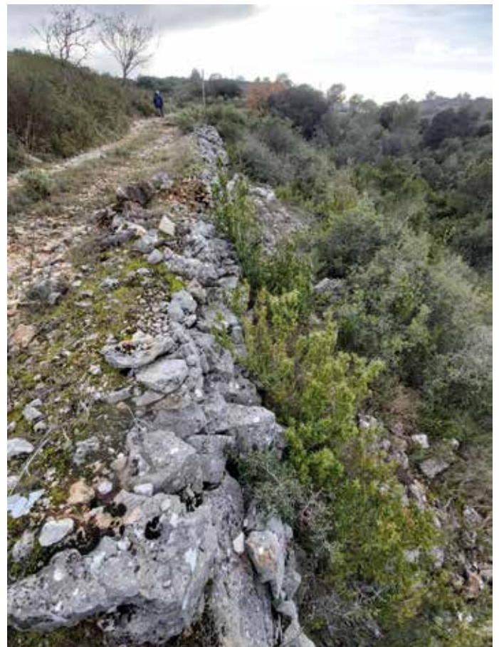
Soutènement de la voie d'Antoninus Le Pieus (138 à 161 apr.JC)
